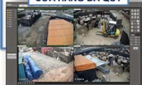
NHÀ XƯỞNG – CÔNG TRƯỜNG
